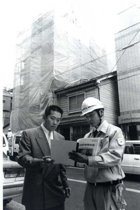
現在請け負っている市内の現場を訪れ、現場監督から進捗状況と今後の見通しの報告を受ける。「請け負った仕事は最後まできちんと仕上げて当たり前。これがわが社のポリシーですから」
